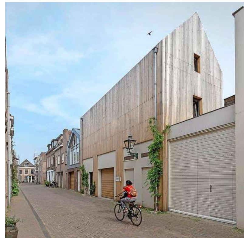
In de Clarensteeg is de houten dakwoning te zien.
